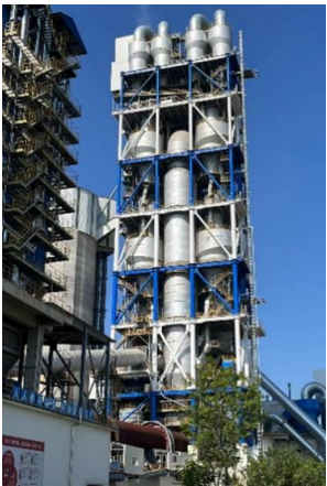
图 3 分解炉现场图片
