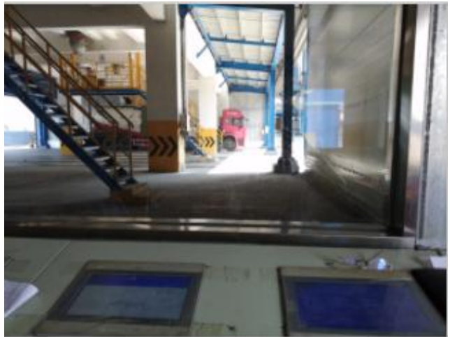
图 10 涉县金隅项目散装控制室观察窗口
