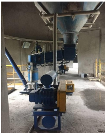
图6 中材常德项目技改前的现场照片
